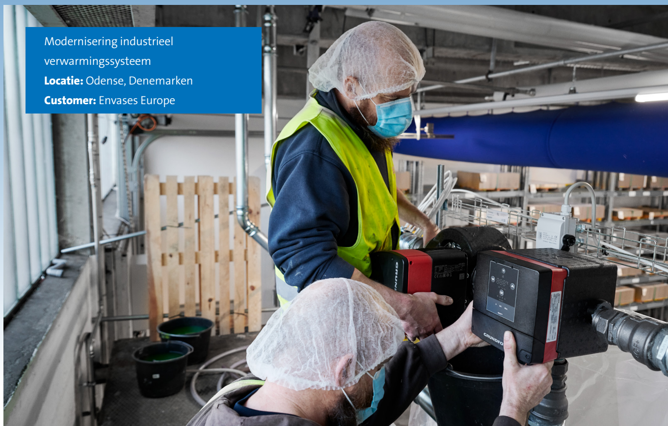
Afbeelding: De installatie van een MIXIT-eenheid naast een MAGNA3-circulatiepomp voor het Envas HVAC-systeem.
