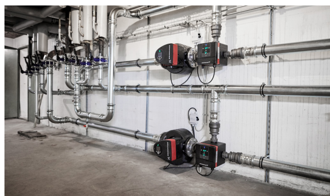
Afbeelding: Twee geïnstalleerde menggroepen met Grundfos MIXITs en MAGNA3's bij Envasen.
