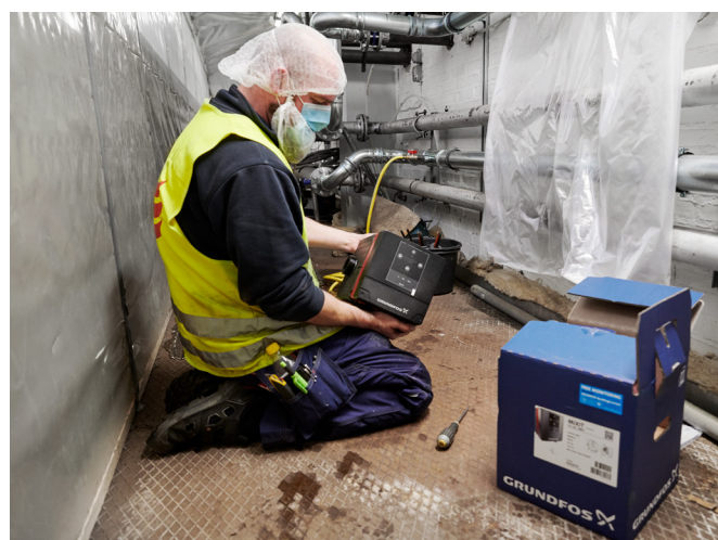
Afbeelding: De installatie van een Grundfos MIXIT bij Envas.
