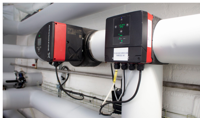
Afbeelding: De menggroep na de modernisering met MIXIT. De Grundfos MIXIT-eenheid bevindt zich rechts. Links is de Grundfos MAGNA3-circulatiepomp geïnstalleerd.
