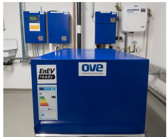
De hoofdwarmtegenerator is een compacte wkk-installatie met een thermisch vermogen van 21 kW thermisch en een elektrisch vermogen van 9 kW.
