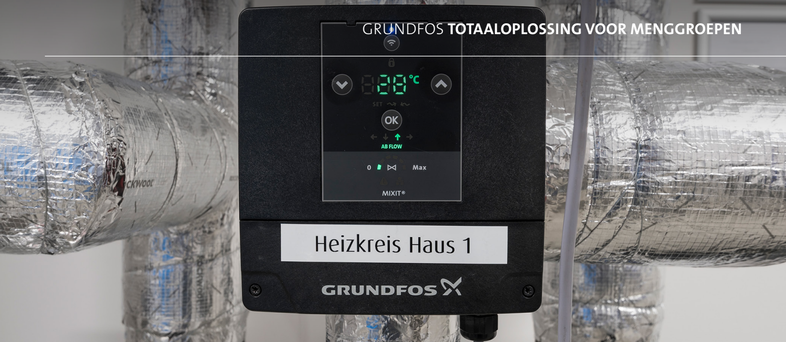
MIXIT-menggroep als driewegklep: A (onder) aanvoerleiding van warmtebron, B (rechts) retourleiding, AB (boven) afgifteleiding
